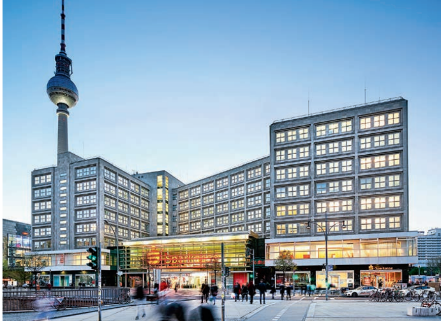
Das Hauptquartier der Berliner Sparkasse am Alexanderplatz
