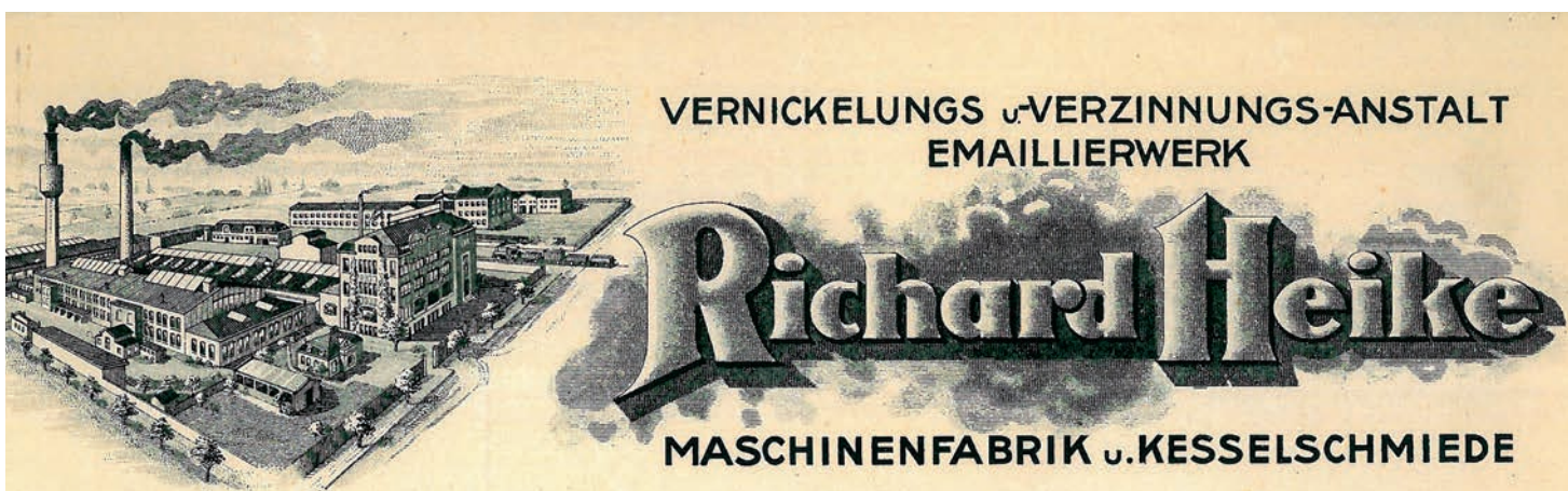
Der Briefbogen aus dem Jahr 1926 war mit dem neuen Werksgelände in Hohenschönhausen bedruckt – und mit dem Namenszug in Fabrikrauch-Optik
