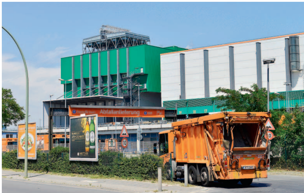
Unter bestimmten Bedingungen kann Abfall verbrannt werden: das Müllheizkraftwerk in Ruhleben
